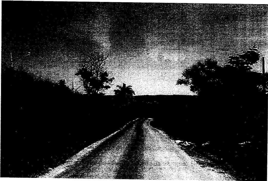
Foto 6 – Antigo acesso marginal a Rodovia LMG 800
